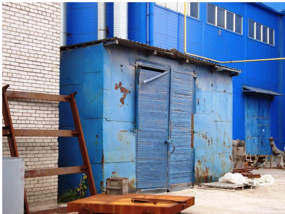
Фото 4. Помещение склада (Лит. БД)
