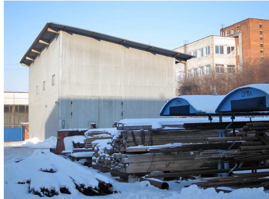
Склад металлопроката. Вид снаружи. Снимок сделан 31.01.2012г.
